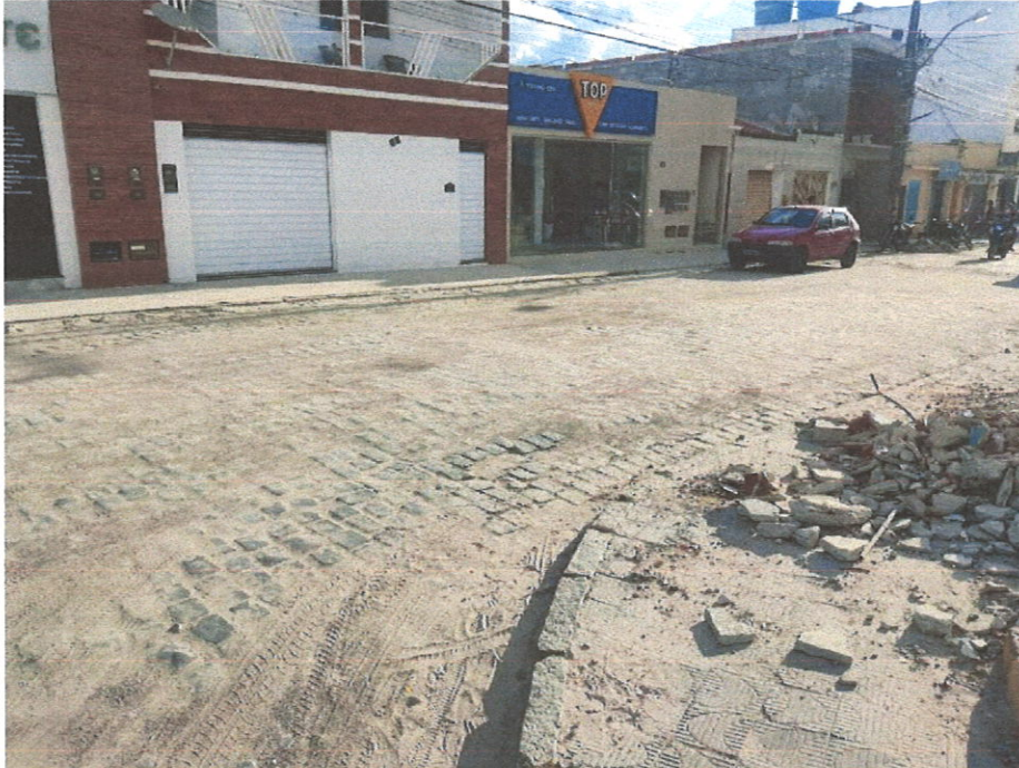
Foto 11- Remoção e reposição de meio-fio
