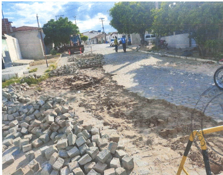
Foto 08- Reassentamento de paralelepípedo, rejuntamento com argamassa/ Aterro com pó de brita - areia
