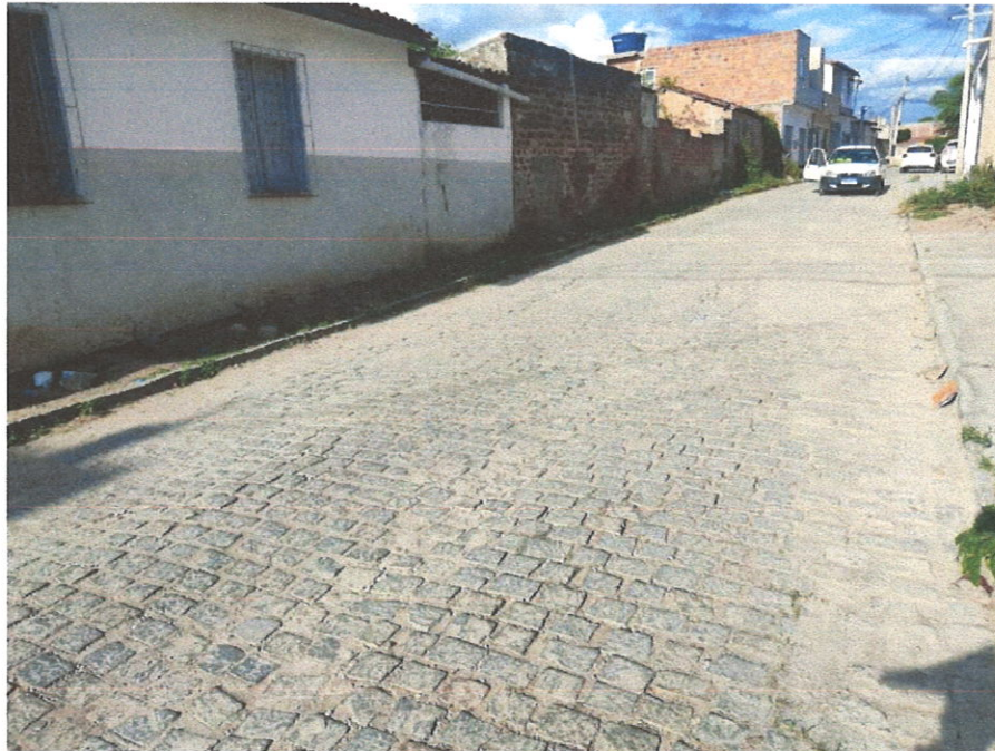
Foto 13- Remoção e reposição de meio-fio
