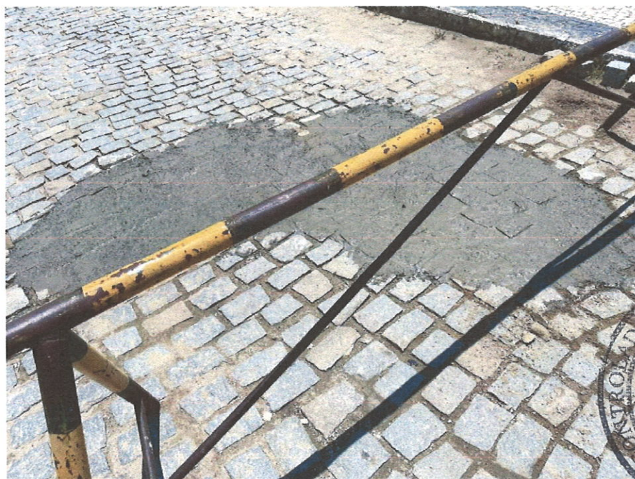
Foto 04- Reassentamento de paralelepípedo, rejuntamento com argamassa.
