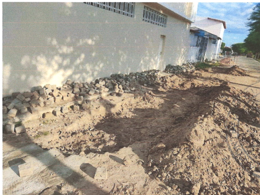
Foto 10- Reassentamento de paralelepípedo, rejuntamento com argamassa/ Aterro com pó de brita – areia
