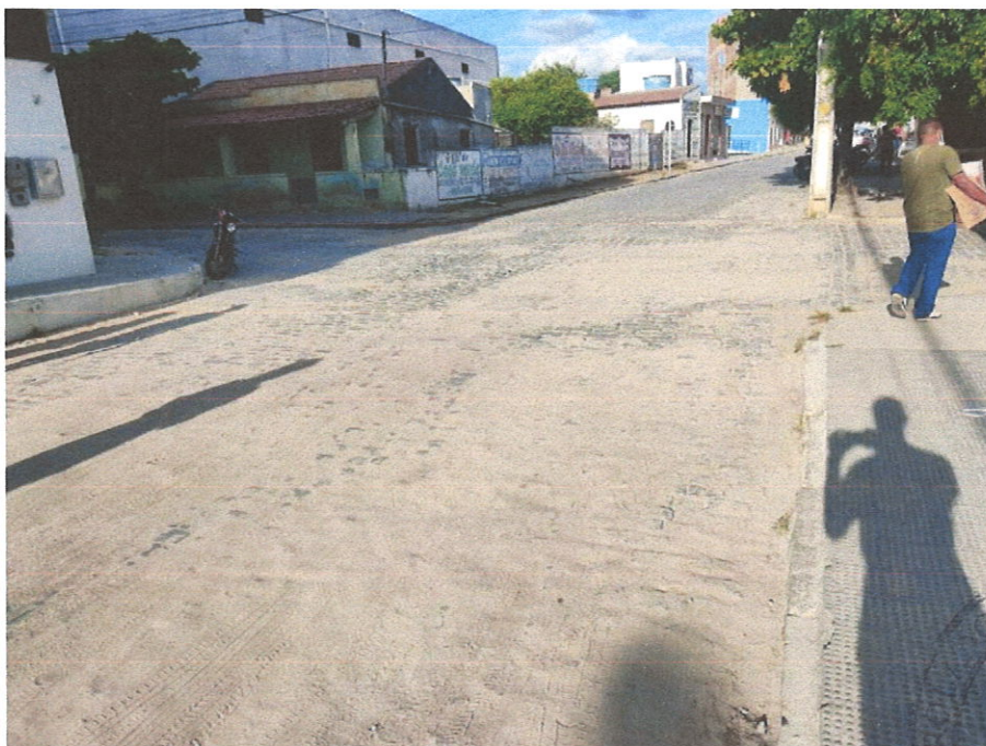
Foto 12- Remoção e reposição de meio-fio
