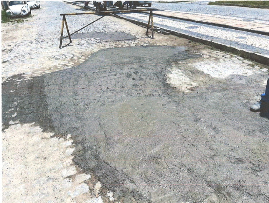
Foto 05- Reassentamento de paralelepípedo, rejuntamento com argamassa.
