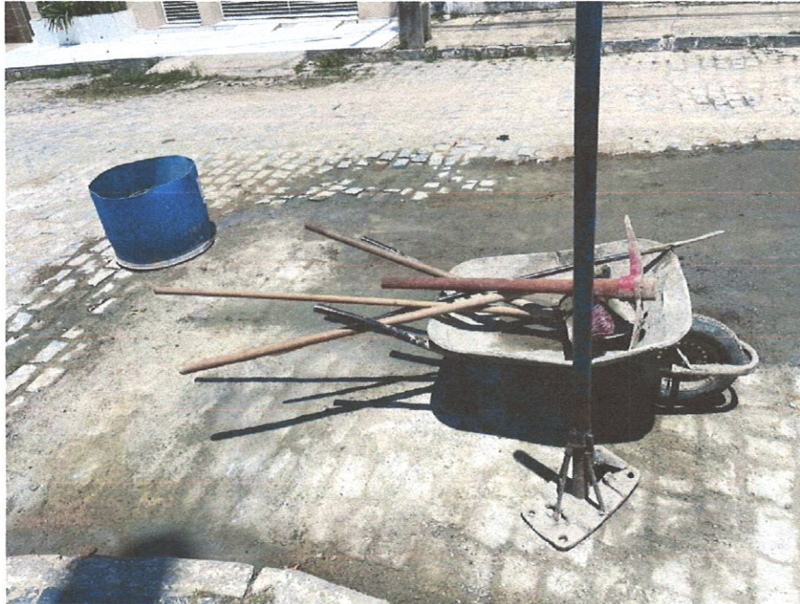
Foto 07- Reassentamento de paralelepípedo, rejuntamento com argamassa.
