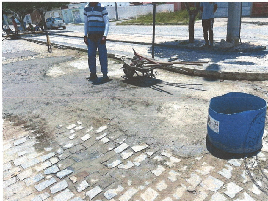
Foto 06- Reassentamento de paralelepípedo, rejuntamento com argamassa.
